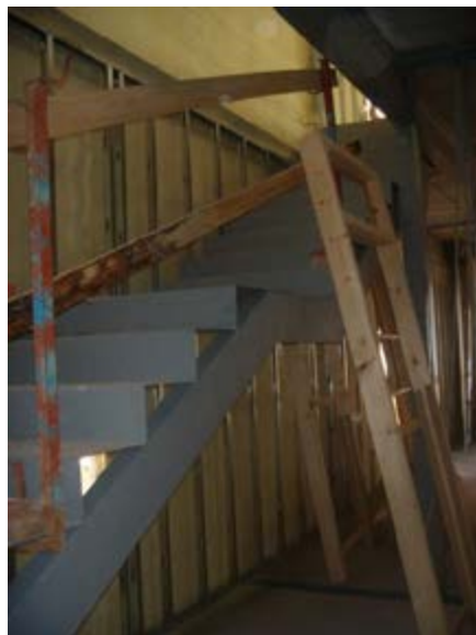
Figura 4. Ejemplo de error con consecuencias económicas limitadas: la escalera metálica de la fotografía generaba vibraciones inadmisibles.
